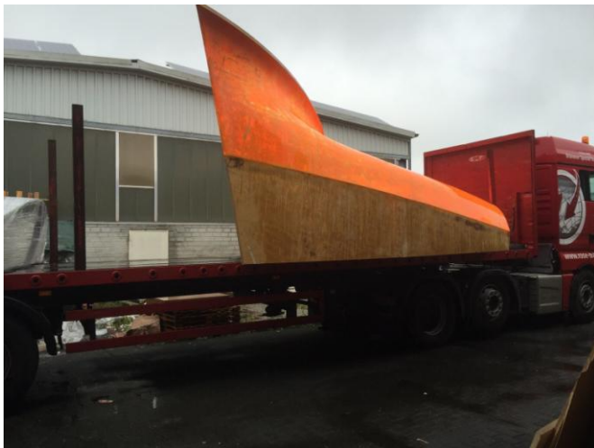
Aufwändige Sonder-Schalung aus Holz für den neuen Hauptbahnhof S21 in Stuttgart
